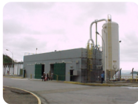
tanque de separação
