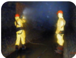
[1] Superfície do Túnel coberta por Bioincrustação e [2] Remoção da bioincrustação
