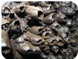
[1] Superfície do Túnel coberta por Bioincrustação e [2] Remoção da bioincrustação
